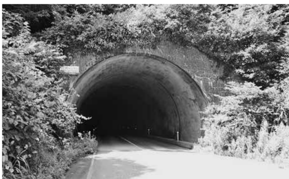
照明のない白沢トンネル
