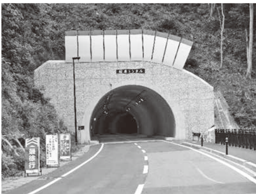
平成 26 年 4 月に完成した桧原トンネル
