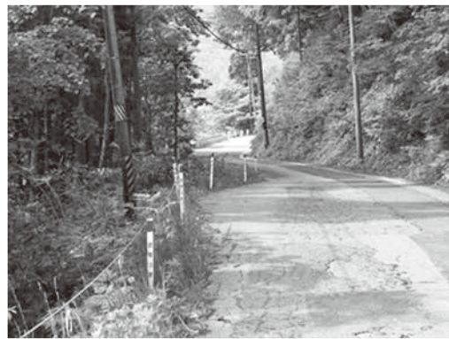
未整備区間（桧原・金山地区）
