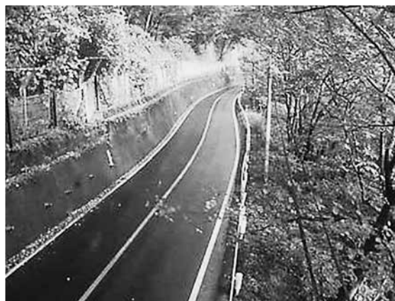
二川橋手前の狭隘な 118 号
