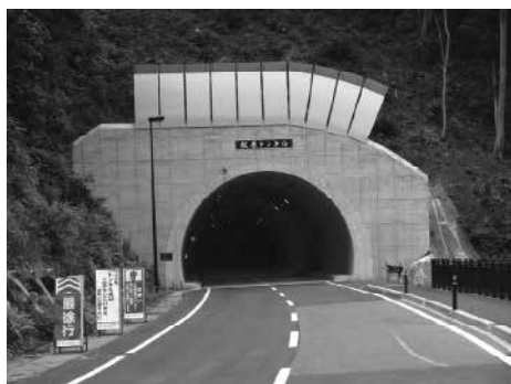
平成 26 年 4 月に完成した桧原トンネル
