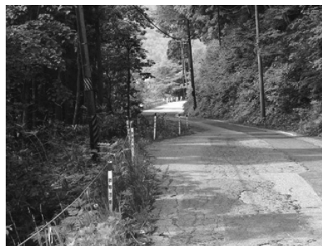
未整備区間（桧原・金山地区）
