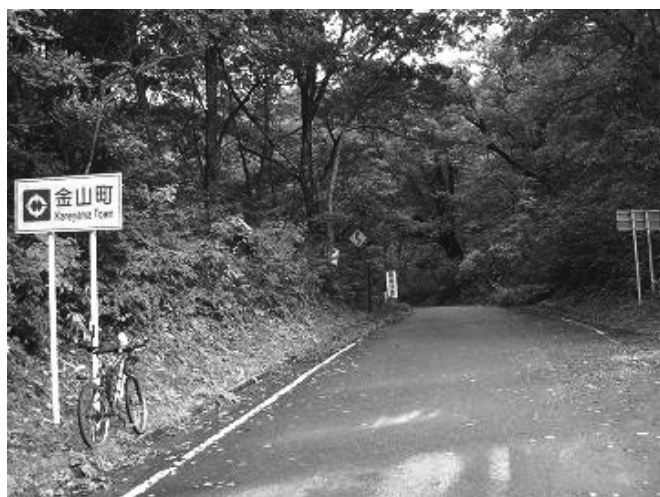
松坂峠(金山町側から)
