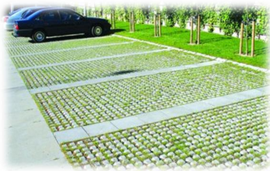
芝生化された駐車場の例
