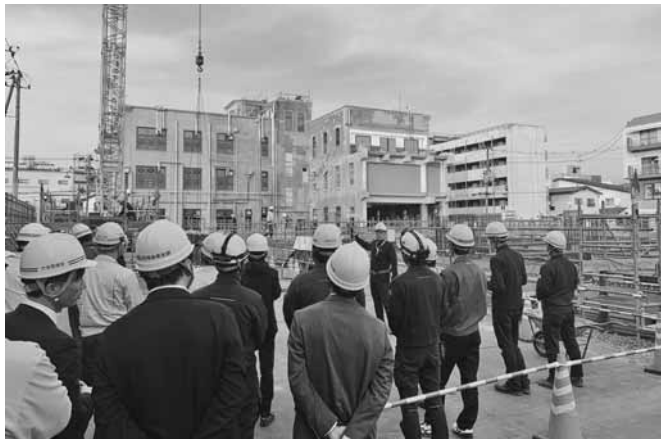
市役所新庁舎建設工事現場見学の様子
