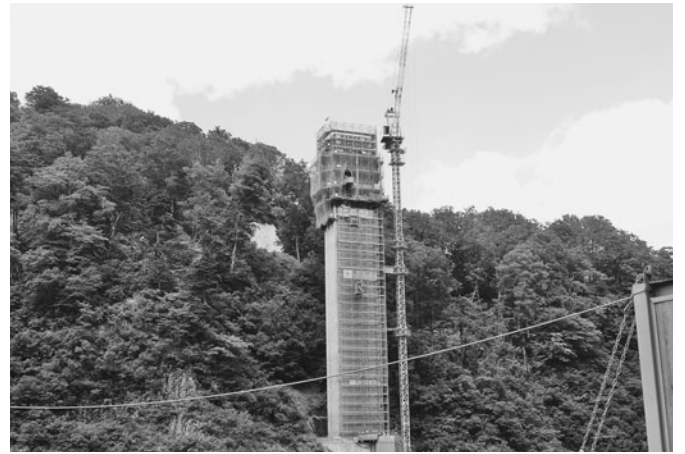
早期完成が望まれる国道289号第5号橋梁工事の様子
