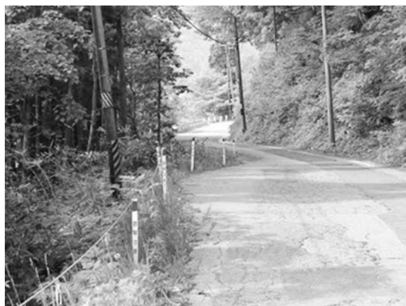
未整備区間（桧原・金山地区）
