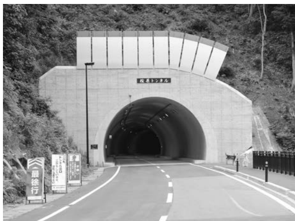
平成26年4月に完成した桧原トンネル
