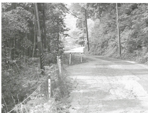
未整備区間（桧原・金山地区）
