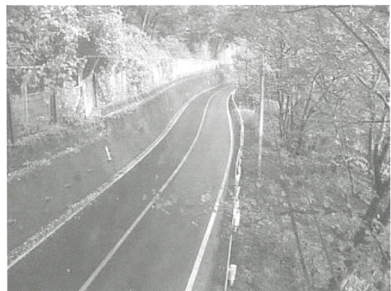
二川橋手前の狭隘な118号
