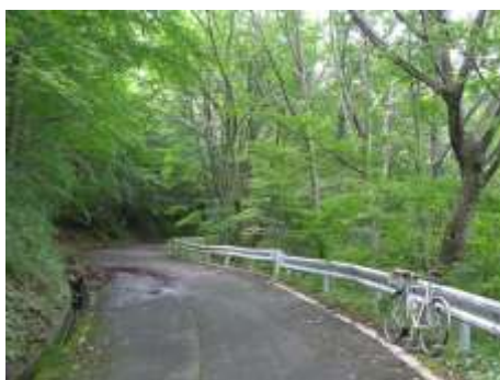
狭隘で未整備な鳳坂峠
