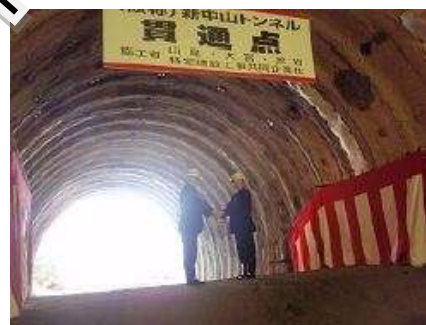
平成24年4月23日の(仮称)新中山トンネル 貫通式
