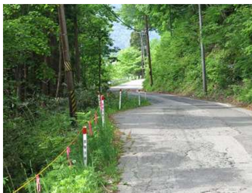
未整備区間（桧原・金山地区）
