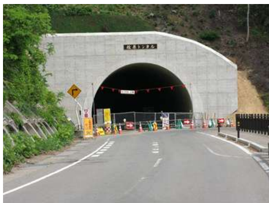
25 年 12 月完成予定の桧原トンネル
