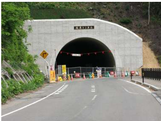
25 年 12 月完成予定の桧原トンネル
