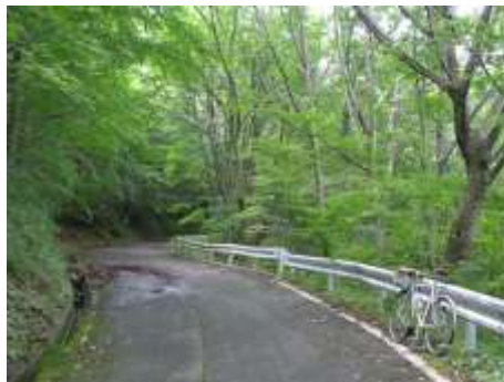
狭隘で未整備な鳳坂峠
