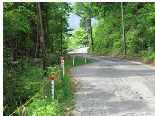
未整備区間（桧原・金山地区）
