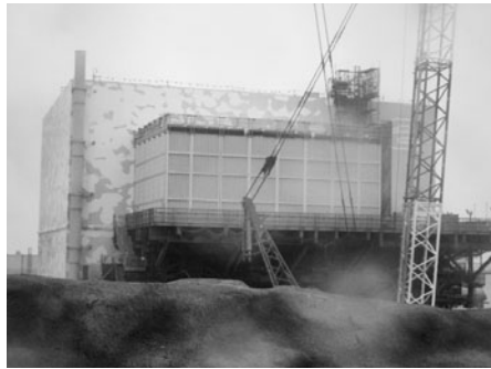
作業が進む2号機原子炉建屋
